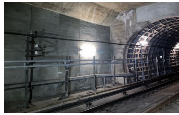
▲大江橋換気塔構築補修
