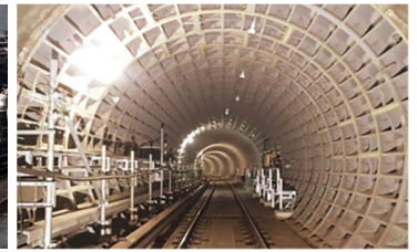
▲シールドトンネル構築補修
