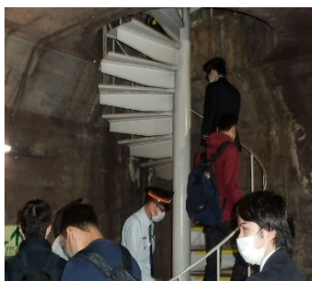
▲換気所（避難階段）
